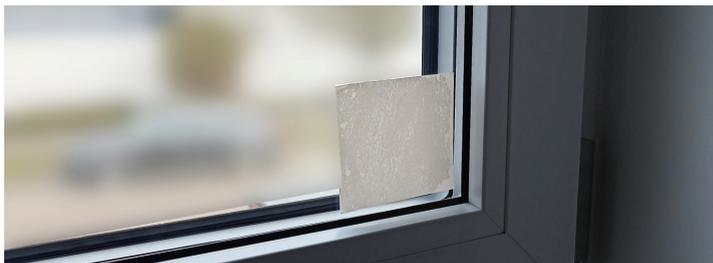
Damit sich die Pins später rückstandsfrei entfernen lassen\* muss auf dem Glas ein Unterlege-Klebepatch angebracht werden. Bei lackierten, eloxierten oder beschichteten Metalloberflächen sowie Kunststoffoberflächen sollten ausschließlich Klebebänder oder Klebefolien genutzt werden, die für diese Anwendung erprobt sind.
